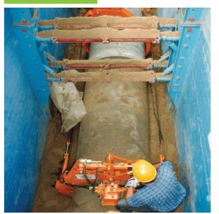
Das einzubauende Rohr wird frei hängend in die Muffe des bereits verlegten Rohres eingeführt, damit sich die Rohrverbindung zwängungsfrei zentrieren kann. Danach wird es in Höhe und Richtung nach Plan ausgerichtet und unterstopft. Verlegekorrekturen durch Drücken, Schieben oder Schlagen mit dem Baggerlöffel sind verboten.
