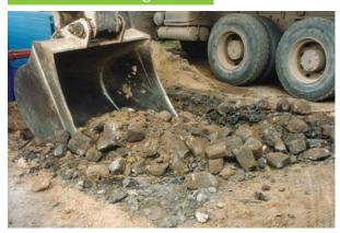
Nach Abstecken der Kanaltrasse wird der Rohrgraben unter **Beachtung der Mindestgrabenbreite** nach DIN EN 1610 und DIN 4124 abschnittsweise ausgehoben. Verdichtungsfähiger Boden wird – soweit möglich – neben dem Rohrgraben zwischengelagert. Zur Verfüllung nicht geeignetes Material wird abtransportiert.
