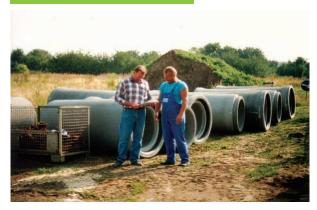
Der Empfänger prüft vor dem Abladen jede Lieferung auf Vollständigkeit und Übereinstimmung anhand der Bestellung. Beschaffenheit und Hauptabmessungen der Rohre, Formstücke, Schachtbauteile sowie des Zubehörs (z.B. Dichtmittel usw.) werden kontrolliert. Den ordnungsgemäßen Zustand bestätigt der Abnehmer auf dem Lieferschein.
