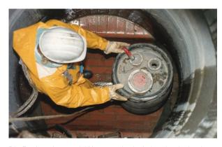
Die Prüfung kann mit Wasser oder Luftüberdruck durchgeführt werden. Die FBS empfiehlt die Prüfung mit 100 mbar (Prüfverfahren LC für feuchte Betonrohre). Die Messergebnisse werden aufgezeichnet.
