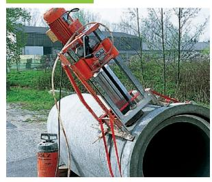
Die Herstellung von Hausanschlüssen sollte möglichst vor der Verlegung des Rohres erfolgen (s. FBS-Richtlinien für den Einbau). Die Herstellung der Öffnung wird mit einem Kernbohrgerät mit einer für das Anschlusssystem passenden Bohrkrone durchgeführt. Der Durchmesser der Bohrkrone sollte aufgrund der Abnutzung ständig kontrolliert werden.
