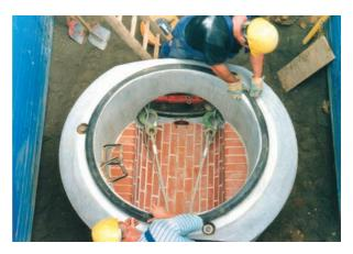
Für Abwasserkanäle und -leitungen sind nur Schachtbauteile nach DIN EN 1917 und DIN V 4034-1 zugelassen, sie haben Muffenverbindungen für Dichtungen aus Elastomeren. Die Gleitdichtungen werden bauseits auf die Spitzenden der bereits verlegten Schachtbauteile aufgezogen.
