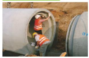
Dichtung und Gleitmittel sind aufeinander abgestimmt; aus diesem Grund darf nur das vom Hersteller der Dichtung zugelassene Gleitmittel verwendet werden. Es wird im Allgemeinen vom Rohrhersteller mitgeliefert. Das Gleitmittel ist bei Rohren mit werkseitig in der Muffe eingebauter Dichtung auf das Spitzende, bei Rohren mit Spitzenddichtung in der Muffe satt aufzutragen.
