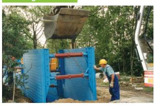
Wenn das Abböschen des Rohrgrabens nicht möglich ist, stützt und sichert ein Verbau die Wände des ausgehobenen Grabenabschnittes. Graben und Verbau müssen den Vorgaben der statischen Berechnung sowie den Unfallverhütungsvorschriften entsprechen und eine normgerechte Einbettung und Verdichtung im Bereich der Leitungszonen ermöglichen.
