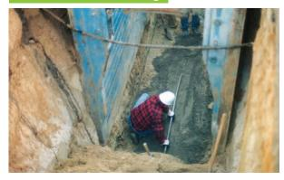
Die Grabensohle ist entsprechend dem Rohrleitungsgefälle herzustellen und während der Verlegung wasserfrei zu halten. Eignet sich der anstehende Boden nicht als Rohrauflager, muss der Boden ausgetauscht werden. Gegen Punktbelastungen sind für Rohre mit Glocke ausreichend große Muffenlöcher auszuheben. Bei Betonbettung liegt die Grabensohle entsprechend tiefer.
