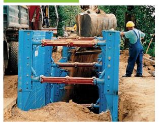
Nach evtl. Wasserdichtheitsprüfung folgt das Einbetten. In der Leitungszone bis 30 cm, mindestens aber 15 cm über dem Rohrscheitel bzw. 10 cm über der Glocke wird gut verdichtungsfähiges Material eingebaut. Der Verbau wird schrittweise gezogen, so kann gegen den anstehenden Boden verdichtet werden. Das nachträgliche Ziehen des Verbaus, z.B. bei Spundwänden, ist statisch abzusichern.
