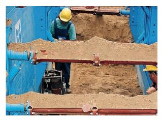
Bis zu einer Scheitelüberdeckung von 1m (im verdichteten Zustand gemessen) dürfen nur leichte Verdichtungsgeräte eingesetzt werden. Je nach Bodenart sind Vibration stampfer bis 60 kg, Rüttelplatten bis 300 kg und Vibrationswalzen bis 600 kg Dienstgewicht geeignet.
