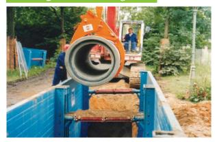
Mit Hebezeugen, die ein gleichmäßiges und feines Heben und Senken erlauben und unter Verwendung von Seilen, Gurten, C-Haken, Rohrgreifern o.ä. werden die Rohre und Formstücke in den Rohrgraben abgelassen.
