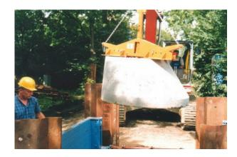
Der Schachtabschluss besteht in der Regel aus Schachthals (Konus) und ggfls. Auflagerringen zur Angleichung an die Straßen- bzw. Geländehöhe und Schachtabdeckung. Bei niedrigen Überdeckungshöhen werden anstelle von Schachthälsen Abdeckplatten eingebaut.
