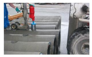
Nachträglich herzustellende Anschlussöffnungen dürfen nur mit einem geeigneten Kernbohrgerät hergestellt werden. Bohrung und Anschlussstutzen müssen aufeinander abgestimmt sein. Die Angaben der Hersteller von Rohren und Anschlussstutzen sind zu beachten. Der Anschlusspunkt sollte bei nicht begehbaren Kanälen bis DN 800 zwischen Kämpfer und Scheitel oder im Scheitel liegen.
