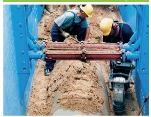
Nach dem Ausrichten wird das Rohr unterstopft und abgelegt. Dabei muss es über die gesamte Länge des Rohrschaftes gleichmäßig aufliegen. Danach wird die Bettung (Auflagerung) hergestellt. Dabei ist darauf zu achten, dass die Verdichtung des Bettungsmaterials in den Rohrzwikkeln mindestens der unterhalb des Rohres entspricht. Die Bettung muss mit den Vorgaben der statischen Berechnung übereinstimmen.
