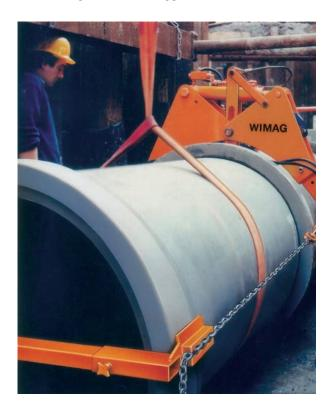
Die Rohre sind in Richtung der Rohrachse zentrisch mit Hubzügen, Winden oder Pressen zusammenzuführen, damit die Dichtung gleichmäßig erfasst und verpresst wird. Das Zusammenfügen mit dem Baggerlöffel ist unzulässig!
