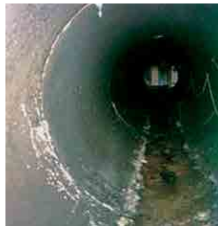
Bild 2: Blick in den Vortriebsrohrstrang DN/ID 1600 mit komplett ausgebranntem GFK-Inliner (das Feuer wurde während der Demontage einer Zwischenpressstation durch einen defekten Schweißbrenner verursacht).
