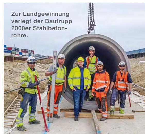
Zur Landgewinnung verlegt der Baupersonal 2000er Stahlbetonrohre.
