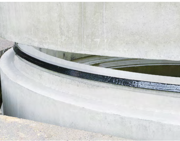
Die Elemente sind mit Dichtungen verbunden
