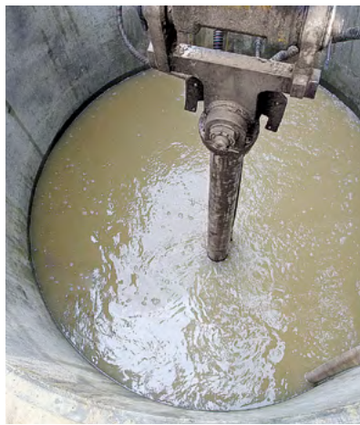
Betonieren der Unterwasserplombe
