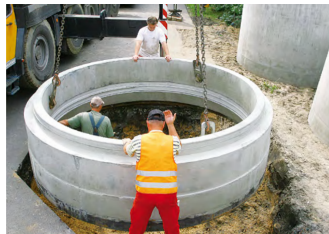
Problemlose Montage durch spezielle Anker
