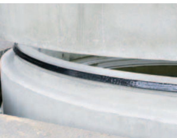
Spojení dílů je zajištěno těsněním
