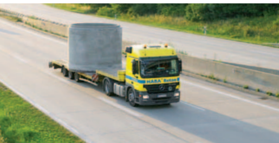
Doprava prvků na stavbu
