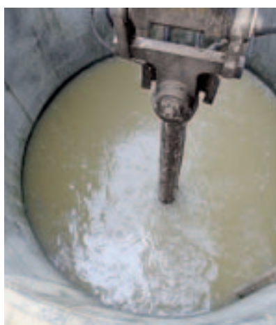
Betonáž dna pod hladinou spodní vody
