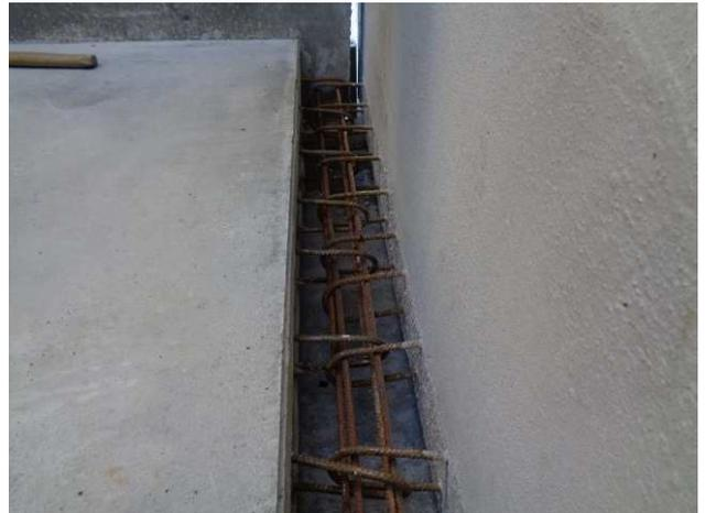
Betonieren der Boden-Boden-Verbindung mit einer Festigkeitsklasse C40/50 mit Größtkorn 16 mm, Menge ca. 40 Liter / m (0,04m<sup>3</sup>).
