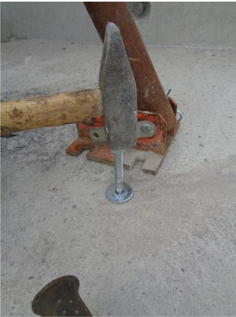
Schlaganker setzen so tief, dass man die Mutter noch eineinhalbmal der Mutterstärke anziehen kann
