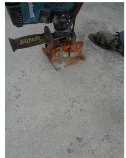
Am Stützenfuß ein Ø 12 mm Loch in den Boden bohren t=mind. 70 mm
