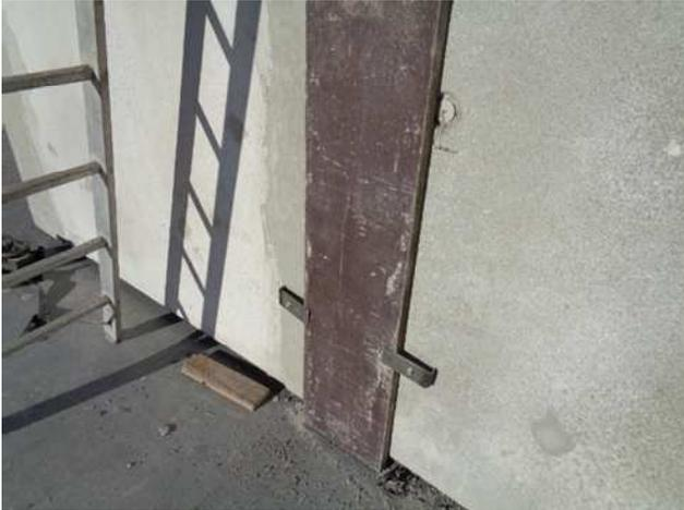
Vollflächig (gesamte) Breite der Fuge abschalen, ausreichende Befestigung → Betondruck!
