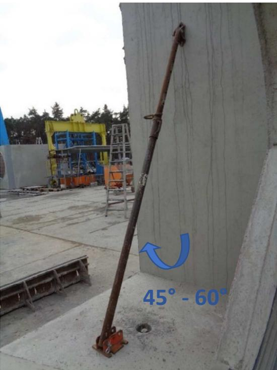
Dasselbe erfolgt an der Innenseite der Wand. Die Stützen stehen ca. 45° - 60° schräg zur Wand
