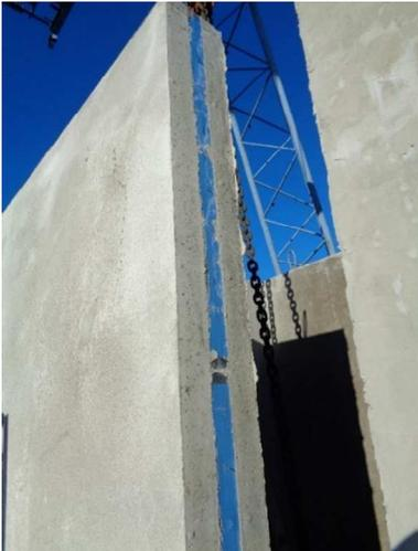
Vor der Positionierung des Bauwerksteils Kunststoffdeckel (blau) mit Hammer oder Beißzange entfernen.
