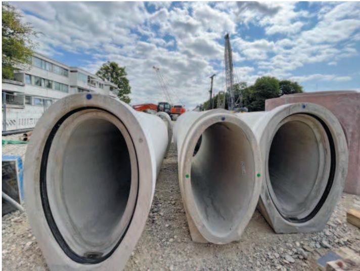
Stahlbetonrohre ÜE 600/1100.
