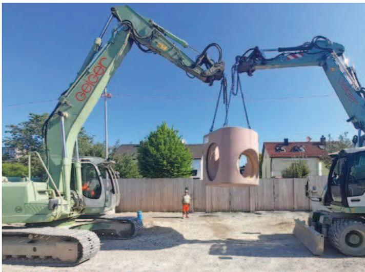
Stahlbeton-Fertigteilschacht mit Hochleistungsbeton.
