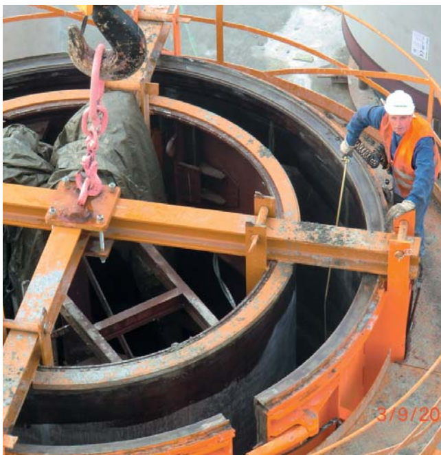
Fot. 2. | Betonowanie rury
