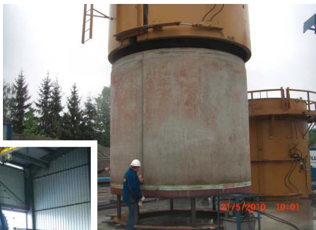
Fot. 3. | Rozszalowywanie rury
