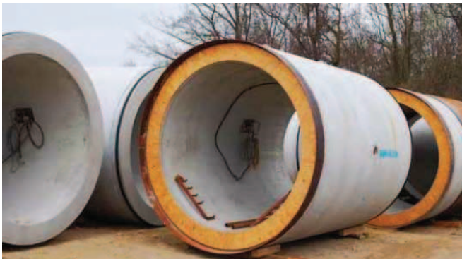
Fot. 1. | Rury do mikrotunelowania DN 2400
