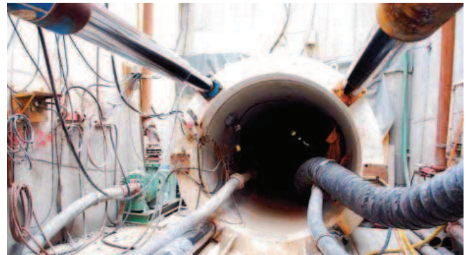
Fot. 2. | Mikrotunel jest najlepszym rozwiązaniem w budowie rurociągu
