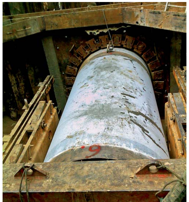
Fot. 3. Prace przeciskowe – Łódź – rura DN1400 HABA-Beton
