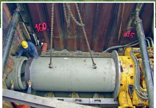
Fot. 2. Rurociąg z betonu B45 DN1000/1280 w odcinkach 3-metrowych
