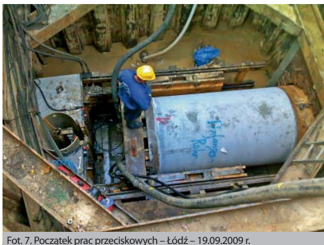
Fot. 7. Początek prac przeciskowych – Łódź – 19.09.2009 r.
