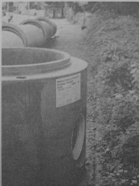
**Für Schmutzwassersysteme mit erhöhtem chemischen Angriff werden Schachtunterteile aus Hochleistungsbeton eingesetzt.**
