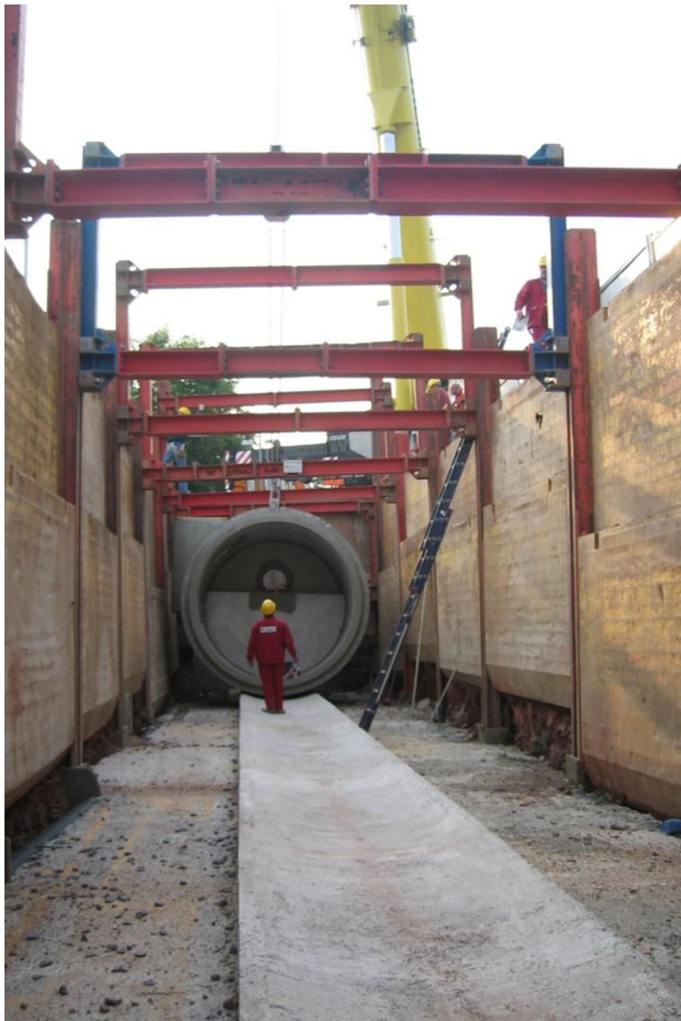
Ausreichend Arbeitsraum: Bei der Verlegung der Rohre reichte das Auflager nur bis 60° in den Kämpferbereich.
