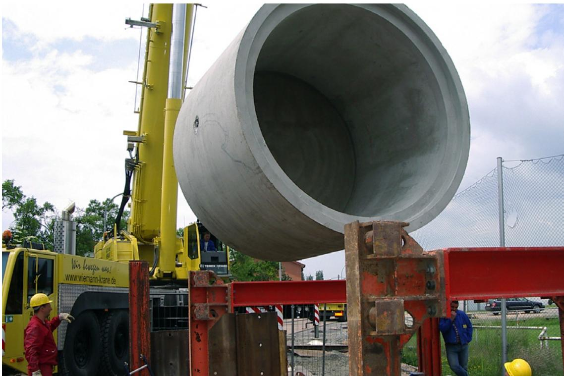
Mit einem Spezialtransporter wurden die 22 t schweren Stahlbetonrohre just in time zur Einbaustelle transportiert und vor Ort mit dem Mobilkran auf das vorbereitete Betonauflager gehoben
