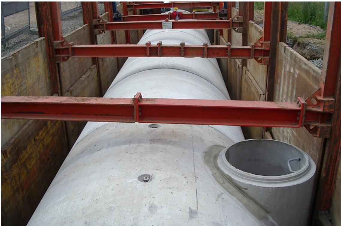
Ein schlüssiges Konzept: Mit der Erstellung des 24 m langen Stauraumkanals wird die Einleitung von häuslichen Abwässern in die Werra deutlich reduziert
