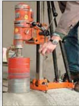
Kreisloch mit Diamant-Bohrkrone rechtwinklig und zentrisch zur Rohrachse bohren.
