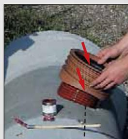
Vor der Montage der Anschlussleitung sind der Dichtring in der Muffe des Stutzens und die Rohrspitze der Anschlussleitung mit **DENSONOX GV** zu versehen. Bei einem abgeschnittenen Rohr muss die Spitze für die Montage angefast werden.
