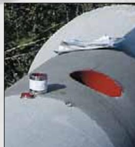
Bohranschlussstutzen zentrisch mit Markierung in Achsenrichtung des Betonrohres bis zum Anschlag in die Bohrung eindrücken. Das zentrische Ansetzen ist wichtig, damit die erste Rippe der Gummimanschette gleichmäßig verpresst wird und nicht umschlägt.
