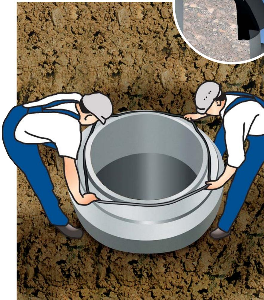
**1.** Dichtung – Gleitmantel nach oben und außen zeigend – auf das saubere Spitzende aufziehen, Vorspannung durch mehrfaches Ziehen an verschiedenen Stellen gleichmäßig verteilen und auf richtigen Sitz der Dichtung an der Schulter sowie des Lastausgleichs mittig auf dem Spitzende achten.
