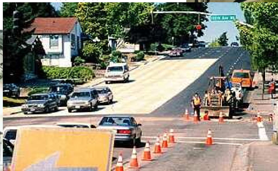
Naprawa nawierzchni drogowych „whitetopping”
