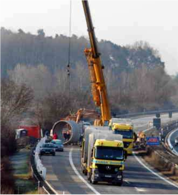
Mächtige Betonrohre lieferte der Kran.
